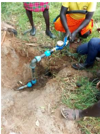
Watermeters zijn geplaatst
